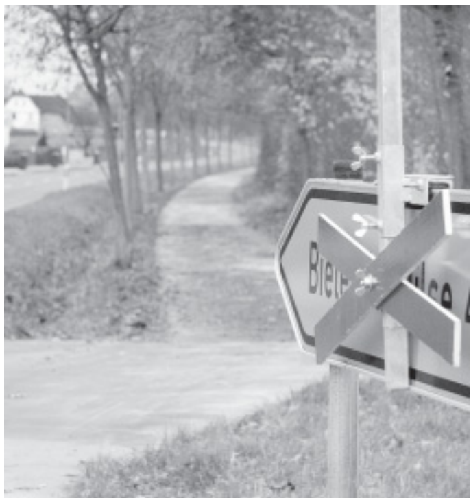
Durchfahrt dicht: Vom Lockhauser Ortsrand ist die Baustelle nicht zu sehen – wer aber abbiegt, kommt nicht weiter. FOTO: SCHRÖDER
